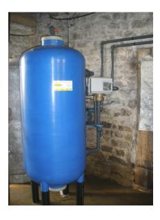
La Neutralisation du PH de l'eau permet d'éviter la dégradation des matériaux (canalisations et chauffe-eau).
